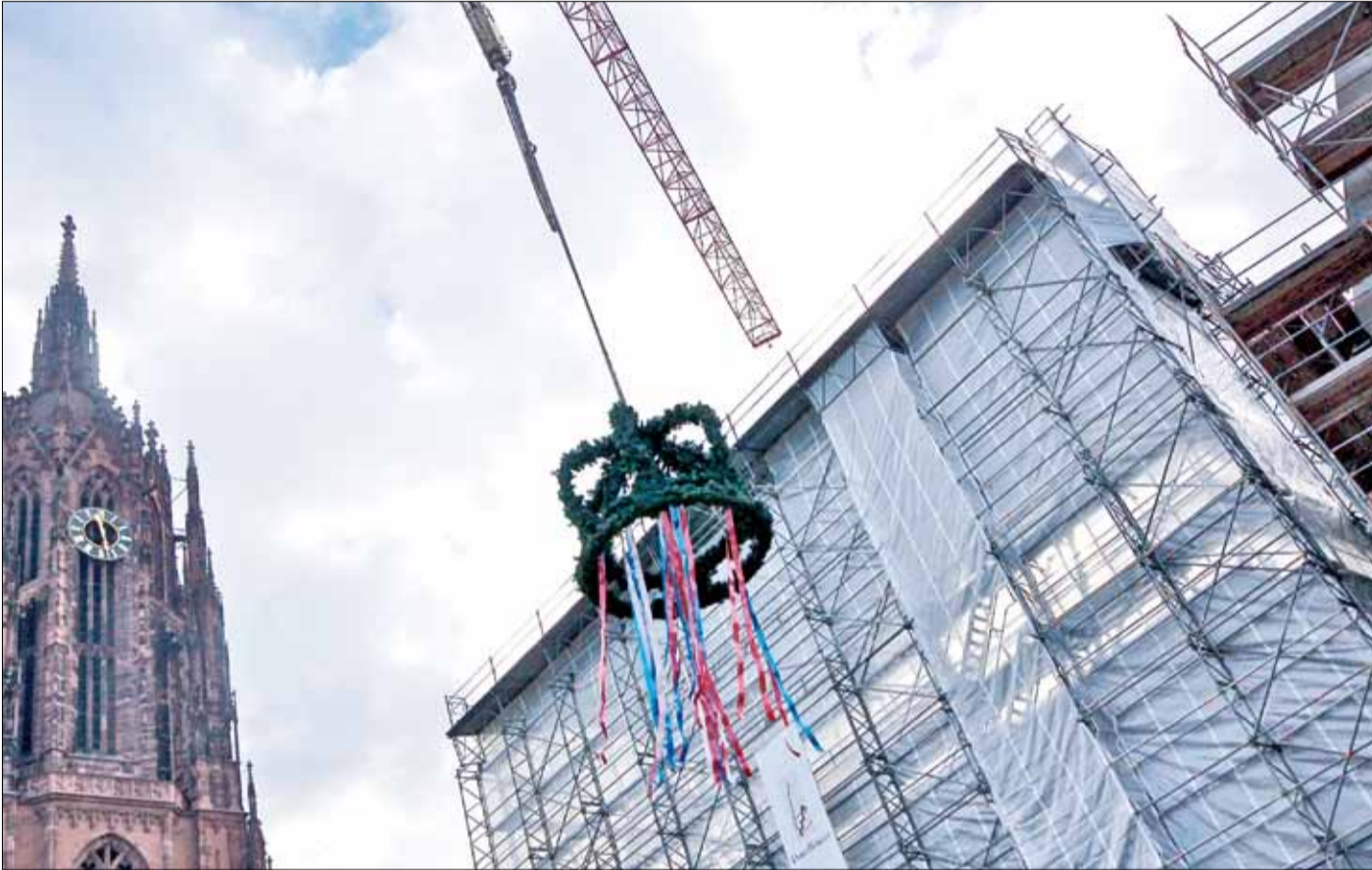
Der Richtkranz wird hochgezogen
