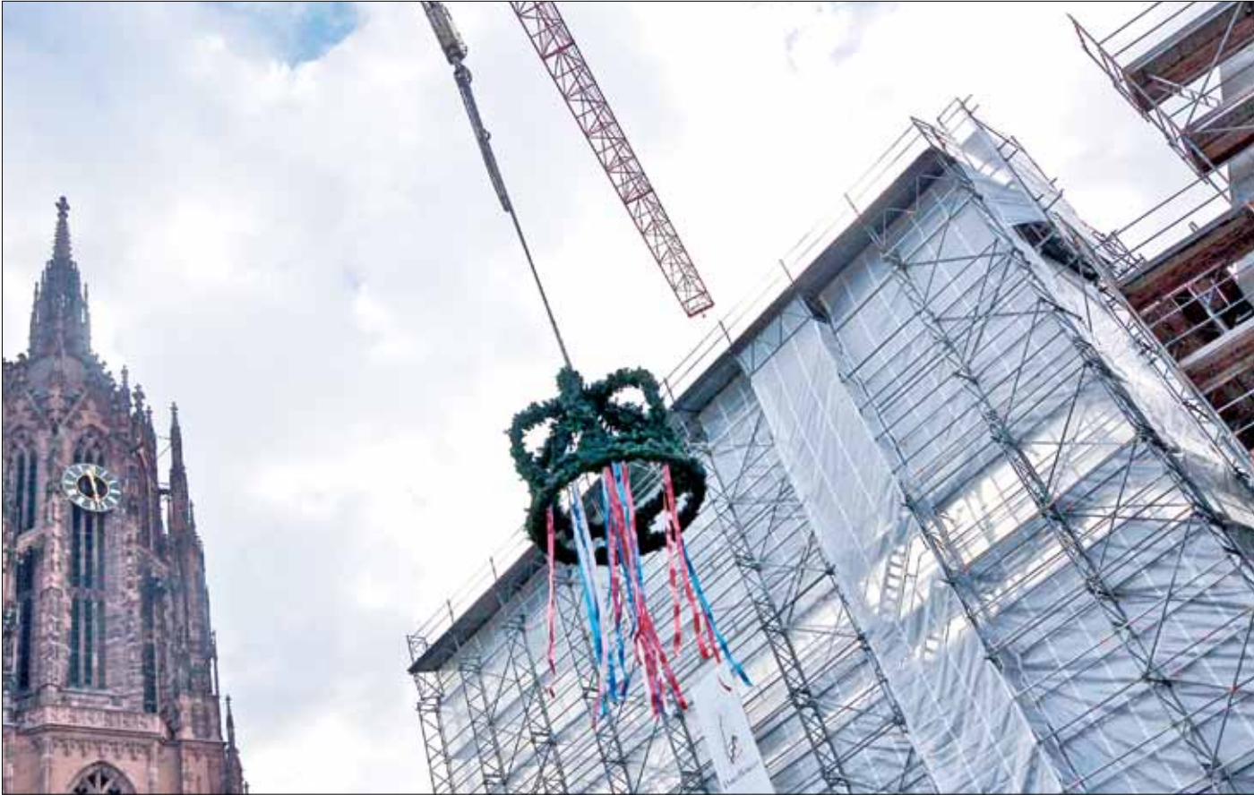
Der Richtkranz wird hochgezogen
