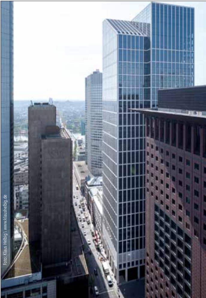
Bankenklamm: Neue Mainzer Straße
